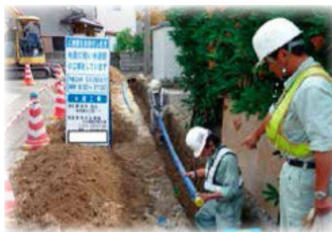
配水支管（写真：配水用ポリエチレン管）
