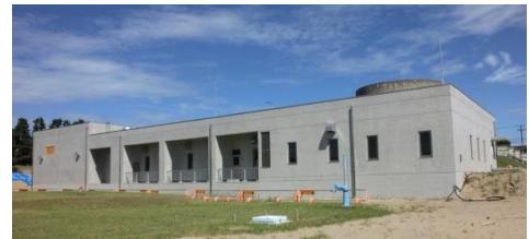
新設された青山浄水場内のポンプ場
