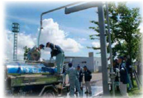
給水車用常設注水設備
