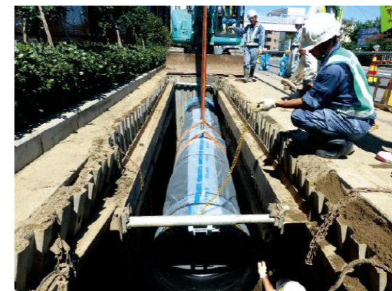
配水幹線布設工事写真（DIP(ps)）
