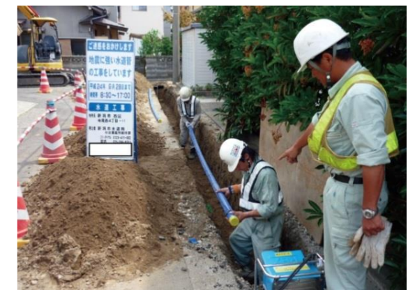
配水支管布設工事写真（HPPE）
