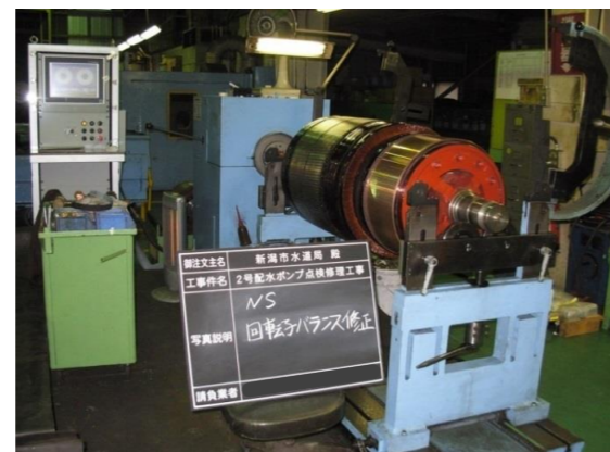
配水ポンプ設備分解整備写真（モーター）
