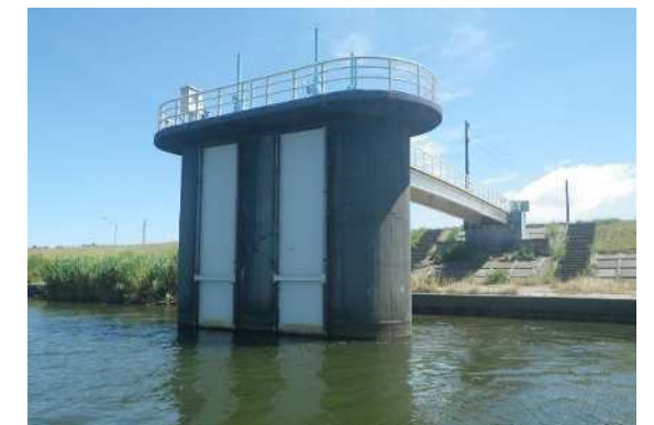
信濃川取水塔外観
