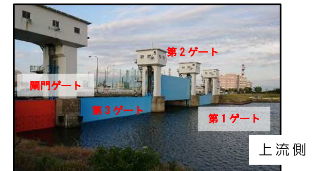
信濃川水門閉鎖状況
