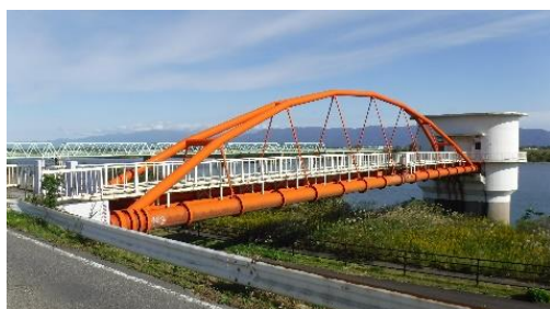
阿賀野川取水塔 ランガー水管橋の全景写真
