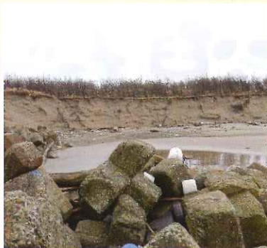
侵食により削られた砂丘
