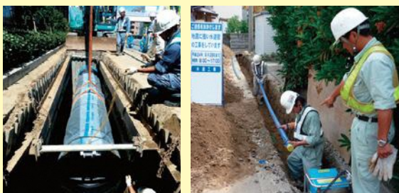
耐震管への更新工事
