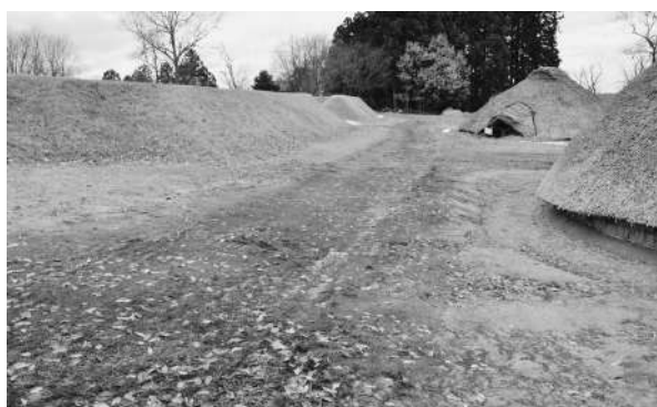
現地検査後の状況（令和4年12月）
