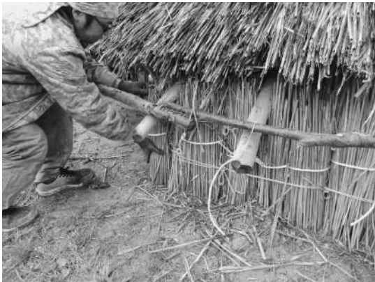
茅葺の復旧 (1号棟)
