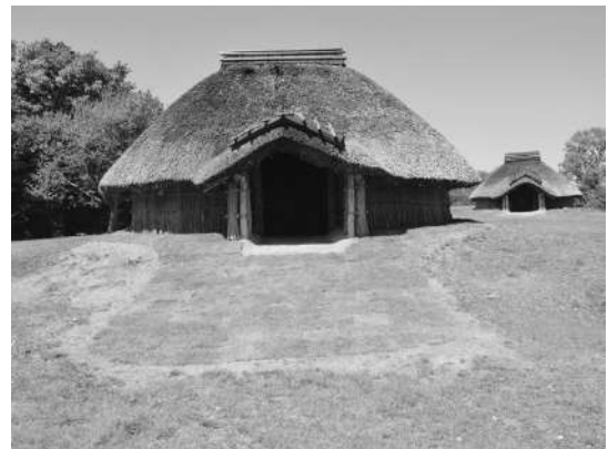
芝生修繕作業後（3号棟 令和5年4月）
