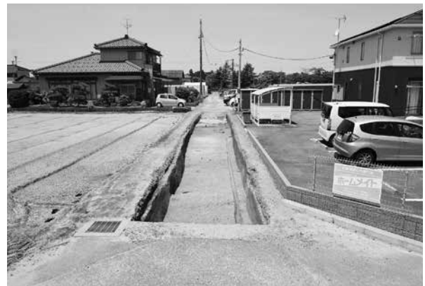
調査区完掘状況 (南東から)
