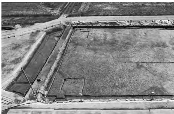
10区 水田遺構全景(北西から)
