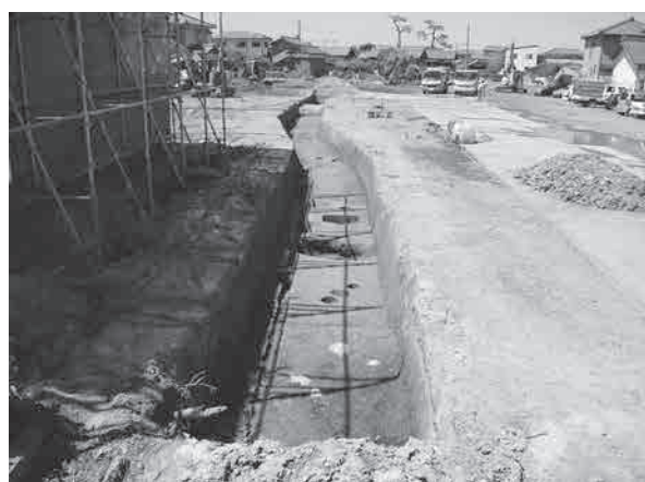
第1次調査10T全景 (南から)
