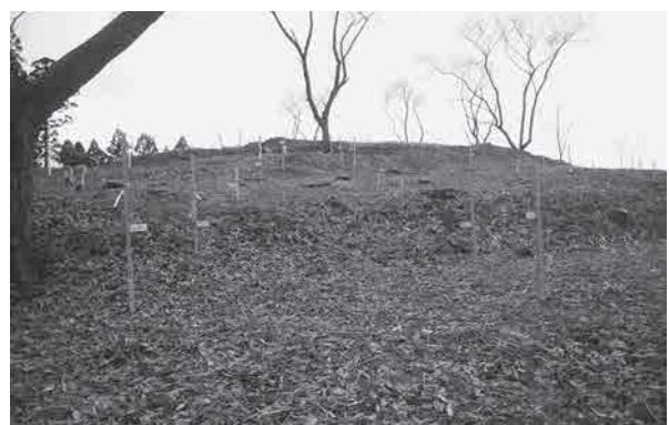
丁張り設置状況
