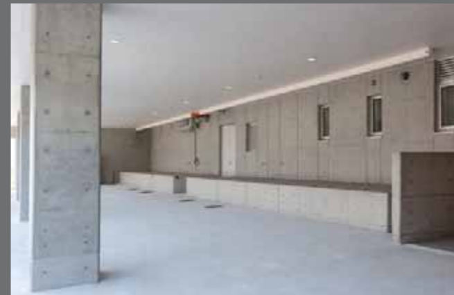
ピロティ木器水槽
