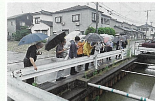
姥ヶ山排水路を視察
