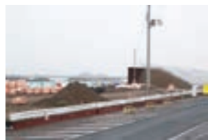
整備中の防波堤
