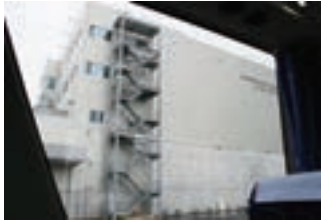
倉庫に付けられた津波避難階段
