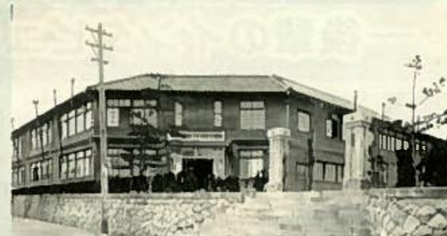
「旧校舎」昭和2年当時の校舎。整備が整い、正面階段が完成。
