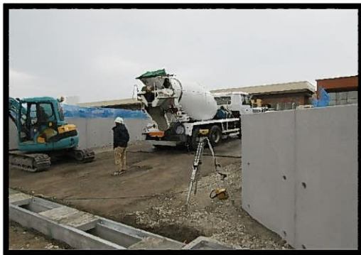
【写真⑬】 出入口2
