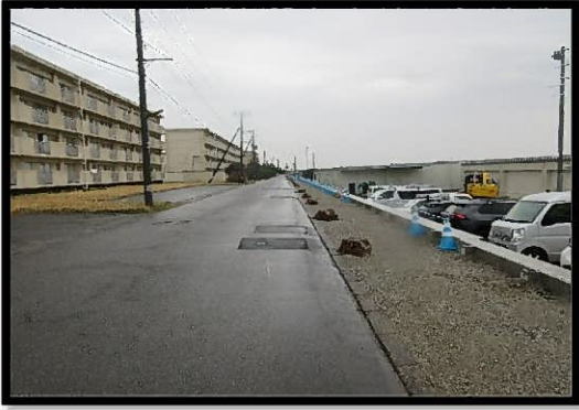
【写真⑰】 松浜住宅との隣地境界
