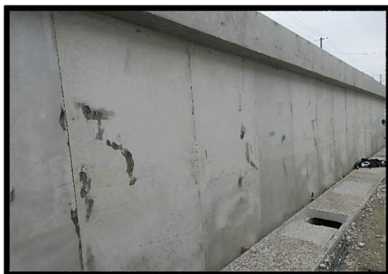
【写真⑦】 建物1～4隣地境界線
