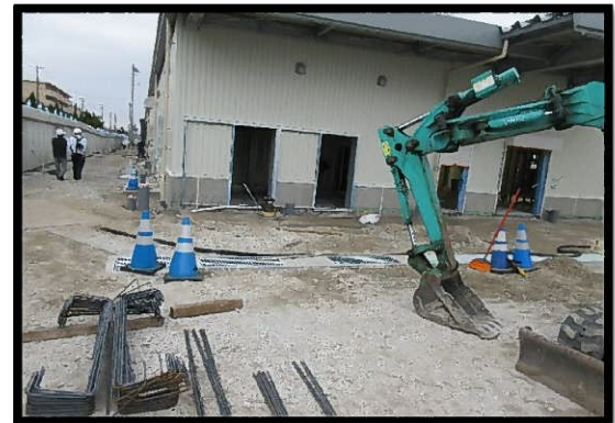
【写真④】 荷さばき施設2及び廃棄物保管施設2～3
