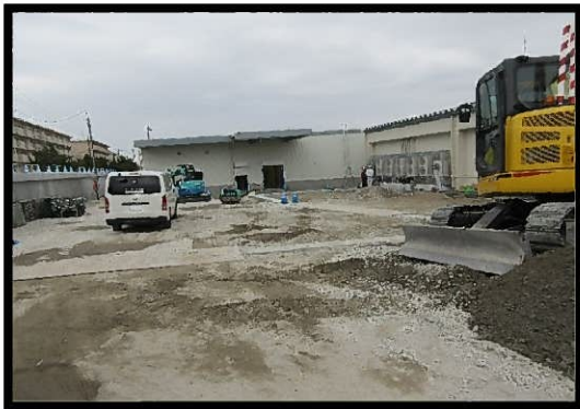
【写真③】 荷捌き施設1及びび2
