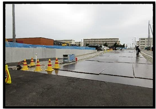
【写真⑫】 国道113号～開発道路前
