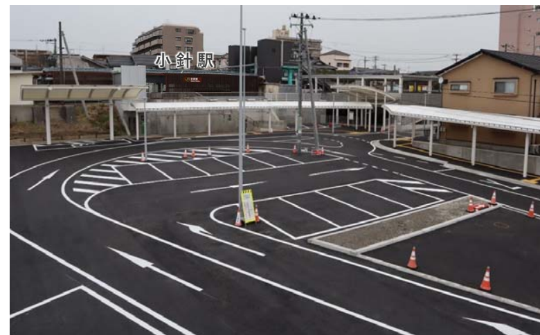
(市)西3-32号線外(小針駅周辺整備)
