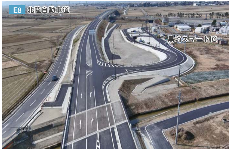
(主)新潟中央環状線(黒崎工区)
