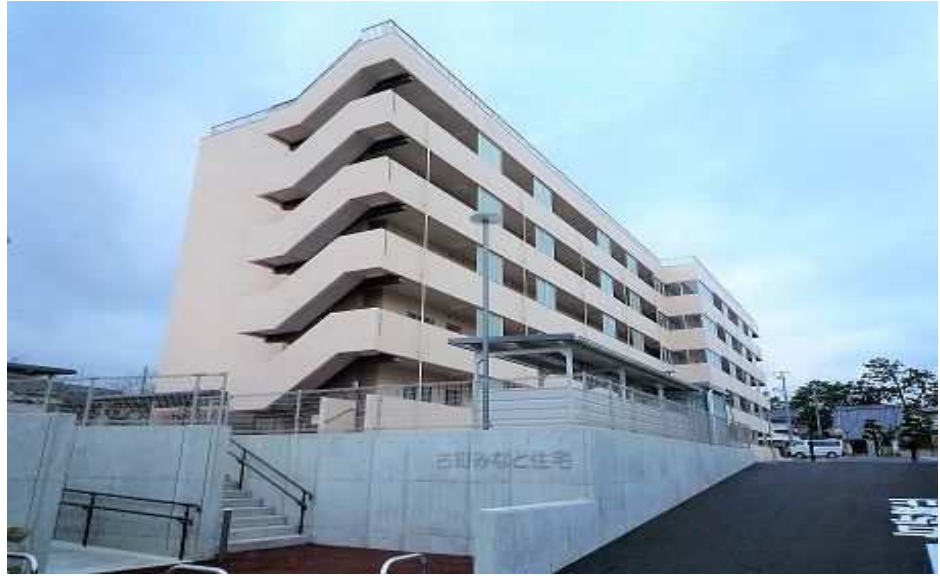
古町みなと住宅
