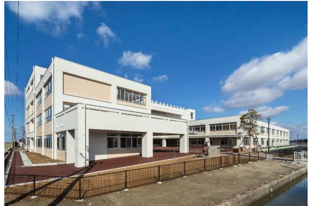
渦東小学校・渦東中学校 令和3年3月竣工
