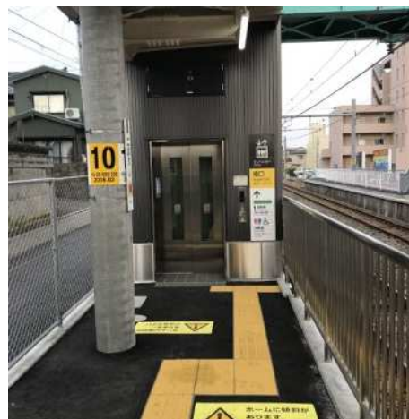
JR 越後線小針駅 (H30 改札内エレベーター整備)
