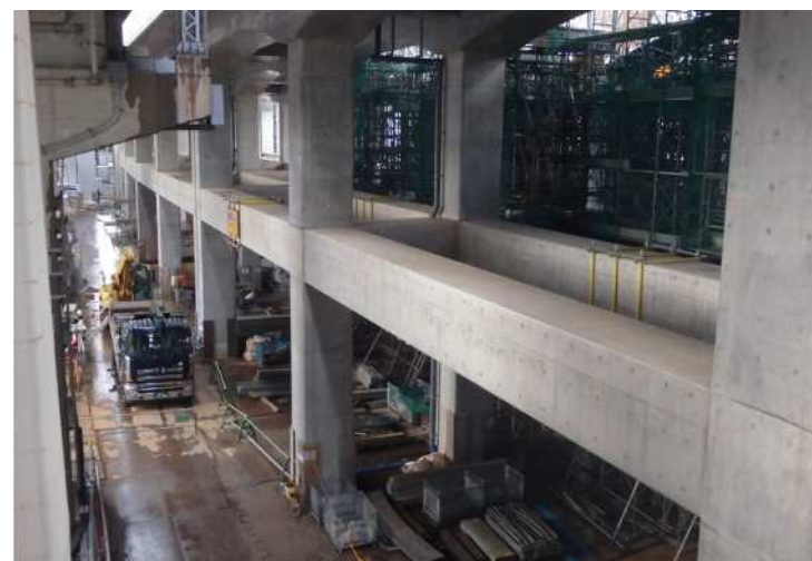
在来線高架化工事の様子
