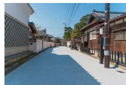
白壁通り 道路改良工事
