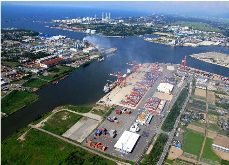
新潟港（東港区）
