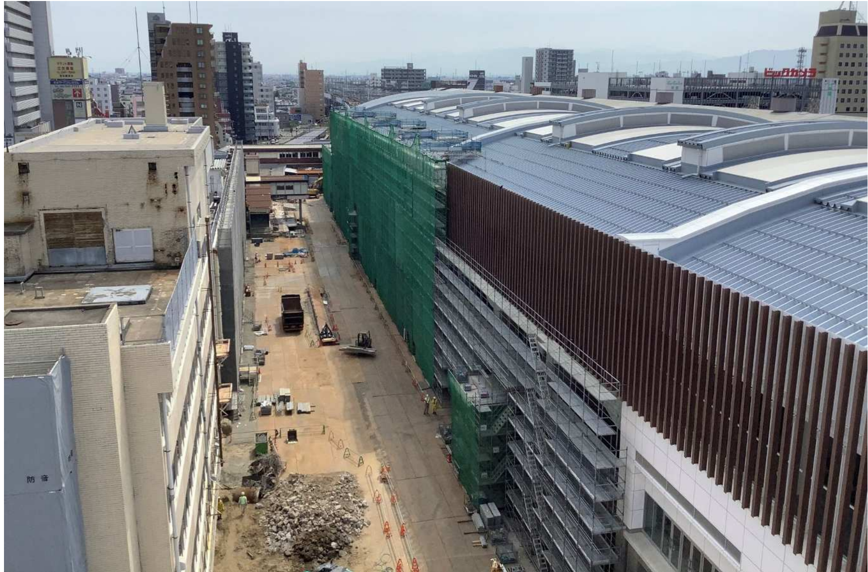
鉄道高架化完成に向けた第二期高架橋工事中の新潟駅
