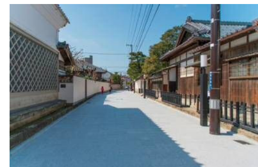
白壁通り 道路改良工事
