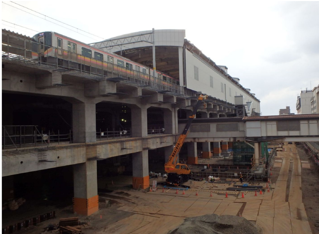
鉄道高架化完成に向け第二期高架橋工事中の新潟駅
