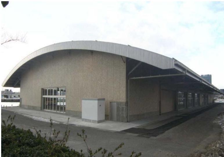
万代島多目的広場「大かま」(平成30年2月竣工)
