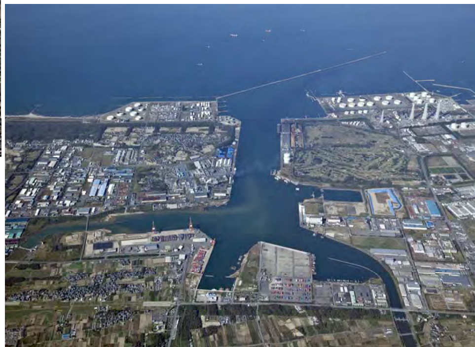
新潟港（東港区）
