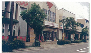
168 サンプロム石山商店街 石山団地 各店舗の看板が個性的で、店舗前の歩道は建物を下げることで広い歩行者空間を作り出すなど、各店舗が個性を発揮しています。
