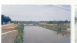
123 新堀排水路 鐘木内 鳥屋野湯南側の国際文化・教育ゾーンの中にあって、鳥屋野湯と一体になった緑の広がりを作り出しています。
