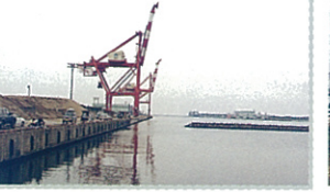
187 新潟東港の景観 環日本海の拠点として、コンテナ貨物や大型船舶が入りし、活気あふれる東港は、正に新潟を代表する港として風格を持っています。
