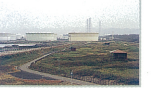
188 東港の工場群 太郎代 石油備蓄タンクが広大に形成され、活力ある工場群の景観は素晴らしい。
