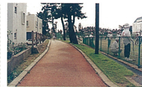
144 西田会スポーツセンターのジョギングコース 五十嵐1 松林の中を走るジョギングコースは、とても気持ち良く走れます。建物も周辺を緑に囲まれ、良い印象を受けます。
