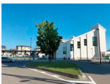
駅前広場・自由通路の整備
