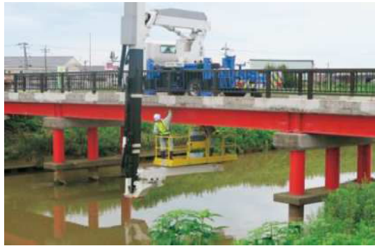
橋りょうの点検
