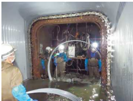
下水道管渠の改築工事
