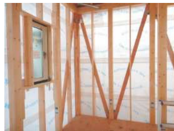
耐震改修(すじかい)のイメージ
