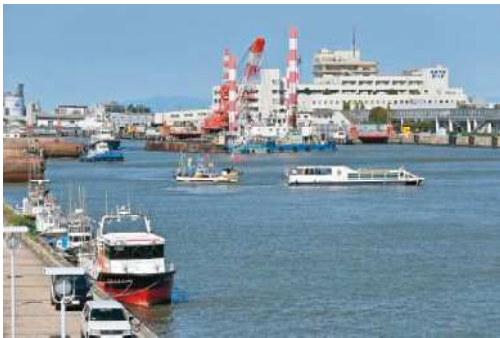
浚渫工事中(応募写真)
