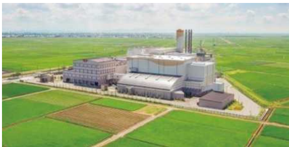
新田清掃センター(ごみ焼却発電所)
