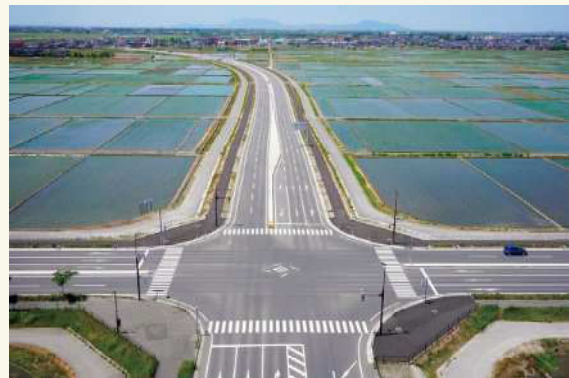
新潟中央環状道路 横越バイパス
