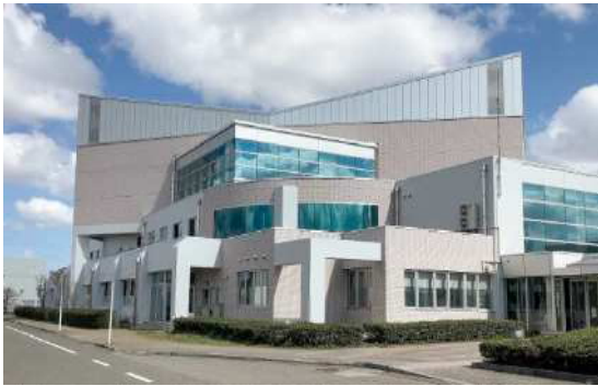
公共施設の長寿命化対策の事例 (屋上、外壁を改修した横越総合体育館)
