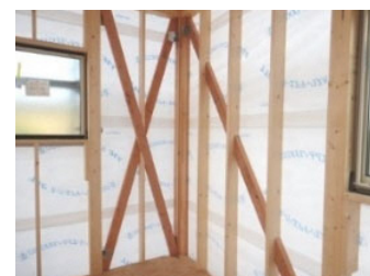
耐震改修（すじかいの設置）
