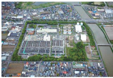
▲中部下水処理場(中央区太右工門新田)。毎日約13万9,000m 3 の汚水を処理。汚泥で作った電気は施設全体の約36%の電力をまかっている
