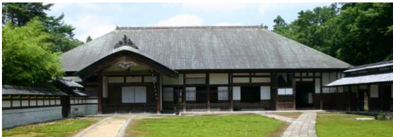
重要文化財旧笹川家住宅
