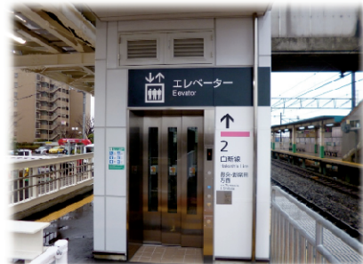
↑ エレベーター設置事例 (東新潟駅)
