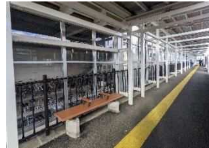
青山結節点上屋改良 令和3年12月
