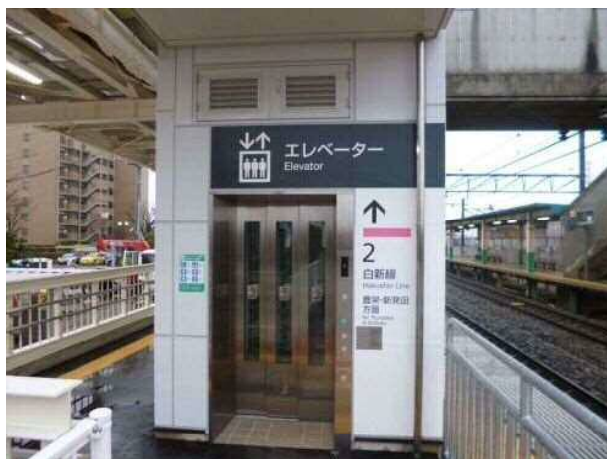
エレベーター設置（JR 東新潟駅）
