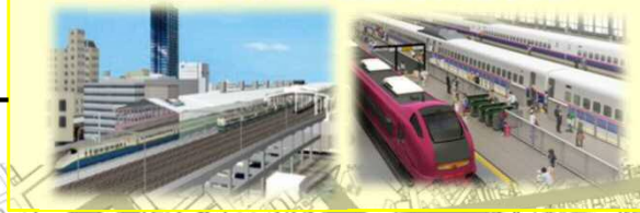
新潟駅付近鉄道高架化事業
