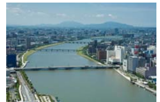
河口側より信濃川上流左岸側を望む
