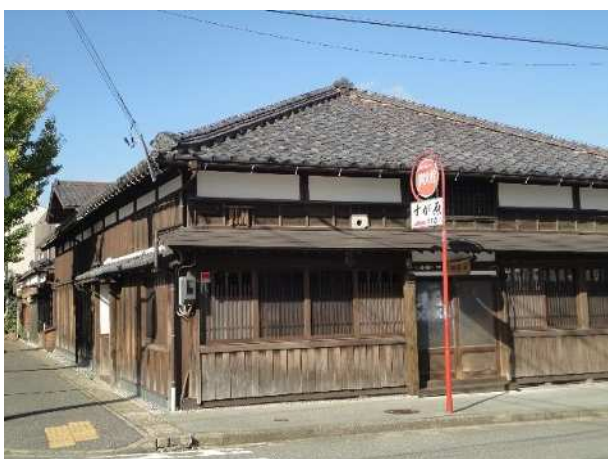
旧片桐家住宅 主屋外観（南東から）
