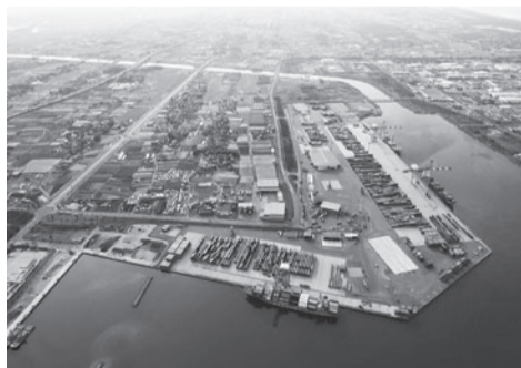
新日本海側最大のコンテナ取扱量を誇る新潟東港コンテナターミナル
