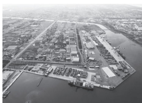
新日本海側最大のコンテナ取扱量を誇る新潟東港コンテナターミナル
