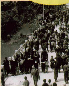
▲懐かしい千隈橋、渡り初めの写真 西川町開町記念誌より
