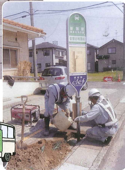
▼移設工事の様子。利用者に不便があつてはならない、と作業は急ピッチで進められました。
