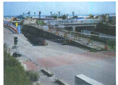
復旧が進む 四倉海岸周辺
