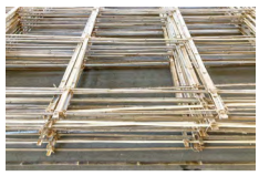
完成した骨組み
