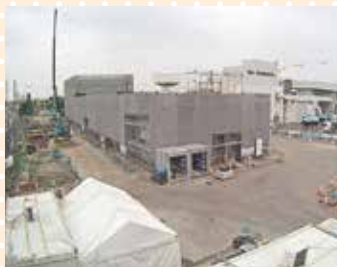
阿賀野川施設整備事業の ポンプ場築造工事
