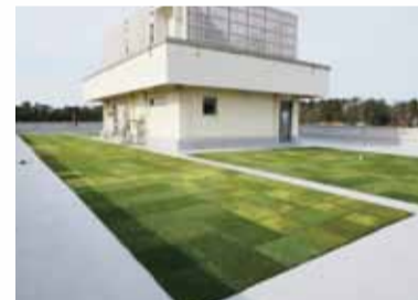
本庁舎屋上緑化
