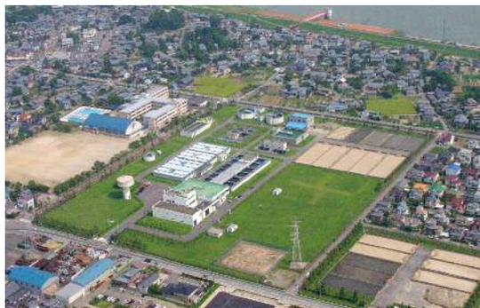
●阿賀野川浄水場では、沈でん池・ろ過池を増設したほか天日乾燥床を採用
