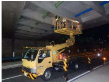
高所作業車による点検
