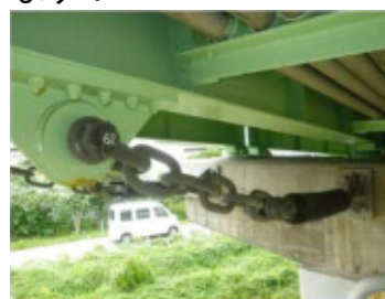
チェーンで桁と橋脚を結合する
