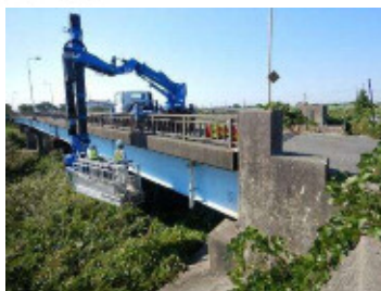
橋梁点検車による点検
