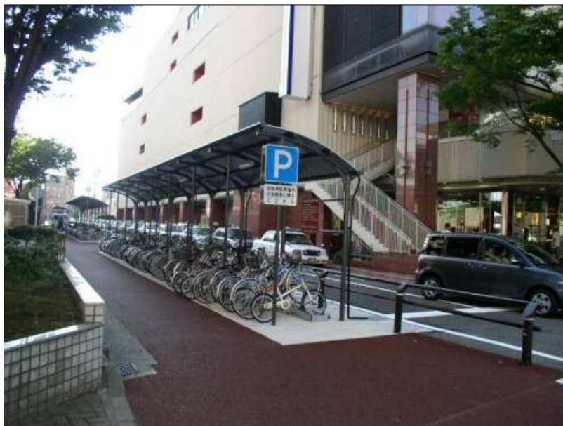
万代地区自転車駐車場(H19年度供用 168台)
