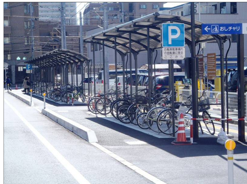
八千代自転車駐車場(H26年度供用 108台)
