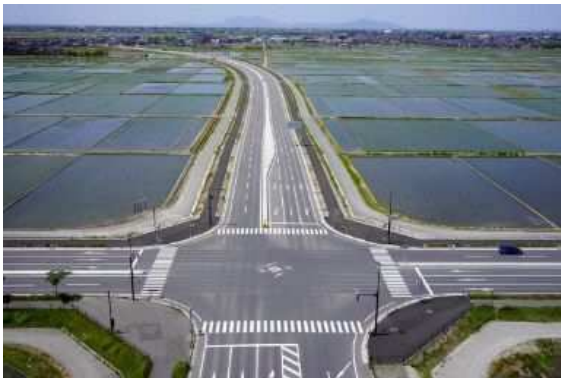
新潟中央環状道路 横越バイパス
