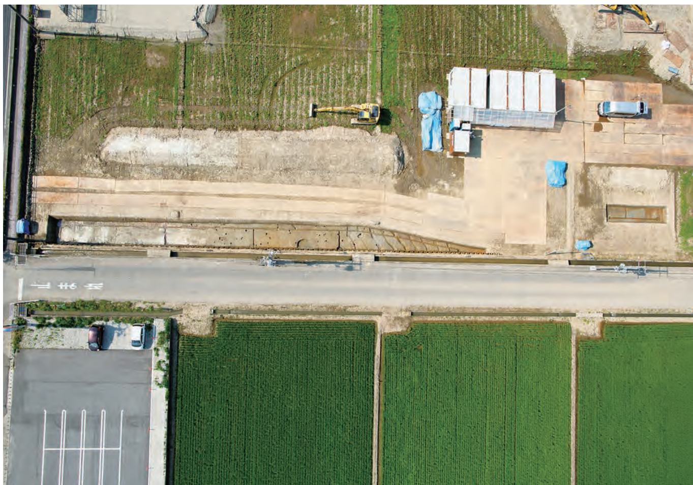
1・2区 空中写真3(南から)
