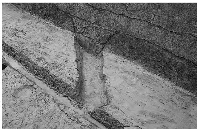
1区 SD37 完掘状況(南東から)
