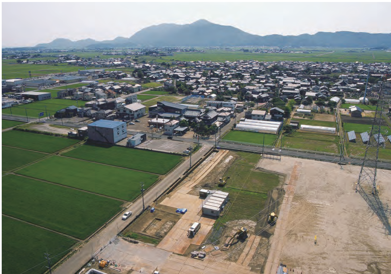
1・2区 空中写真1（北東から）
