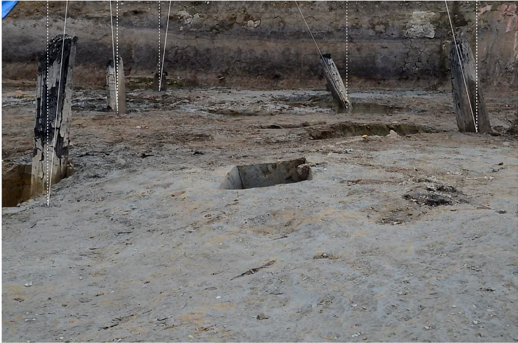
正面から見ると、左右の柱が「ハ」の字状に内側へ傾いています。
