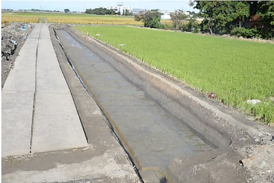
水田遺構完掘状況（南西から）
