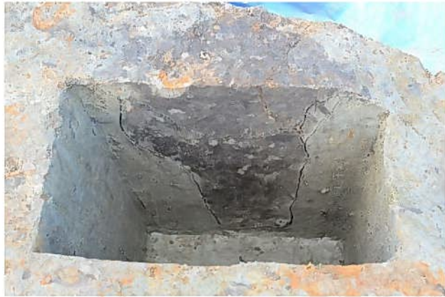
P37断面 (北西から)
