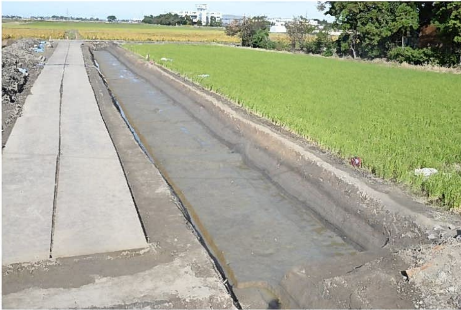
水田遺構完掘状況（南西から）
