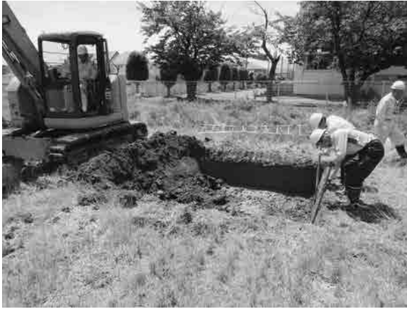
試掘調査風景 (2019117・鷺ノ木新田地区)
