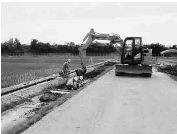
工事立会風景 (2019127・茶院A遺跡)
