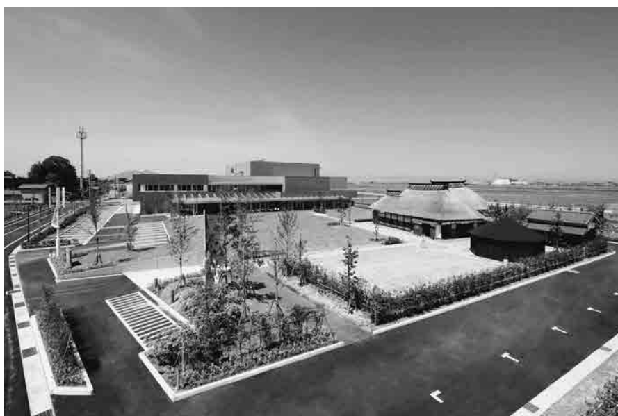
新潟市文化財センター及び旧武田家住宅
