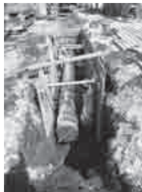
工事作業風景
