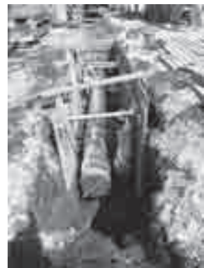
工事作業風景
