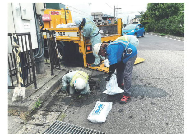
▲業者による側溝清掃の様子
